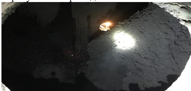
Рисунок 5 – Переход из аптейка в радиационную часть КУ после первого периода испытаний
